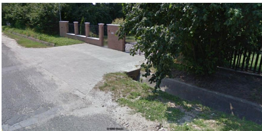
Az Ibolya utcai kiépített árok (forrás: Google Earth Pro)
