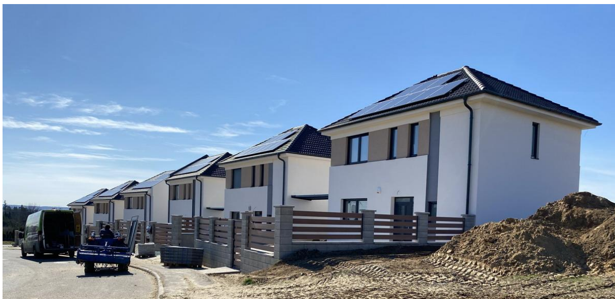
A Kard utca menti épületegyüttes: kiépített útburkolat és járda
