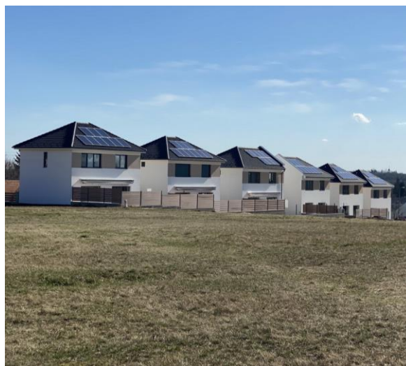
Az épülő beépítés a Korona tér felől
