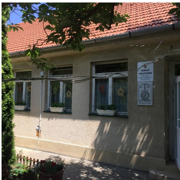
A „Kikelet” óvoda épülete
