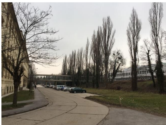
A SZIE épületei a feltáró út két oldalán
