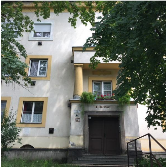
Műemléki lakóépület bejárata
