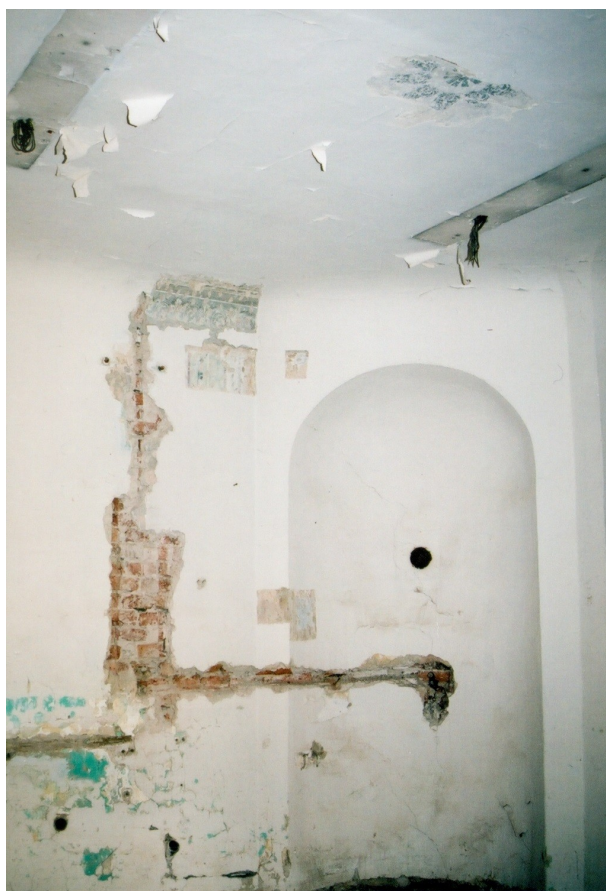
19-20. A párától hámló mennyezetfestések, és a bontási munkák miatt sérült északkeleti fal
