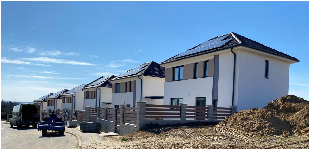
A Kard utca menti épületegyüttes: kiépített útburkolat és járda
