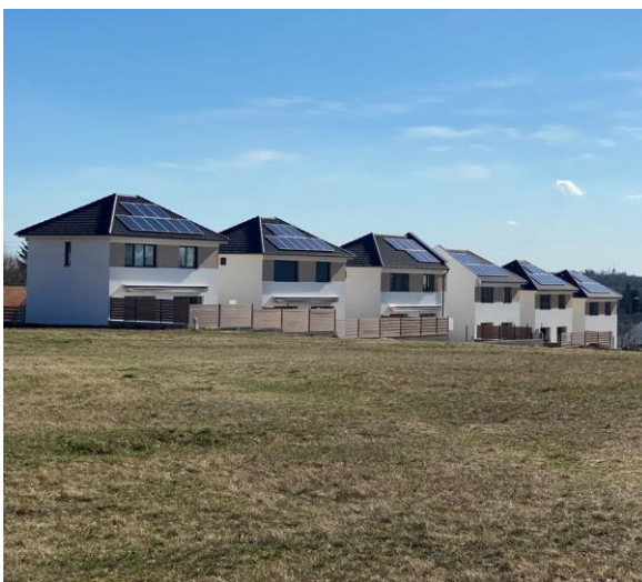
Az épülő beépítés a Korona tér felől
