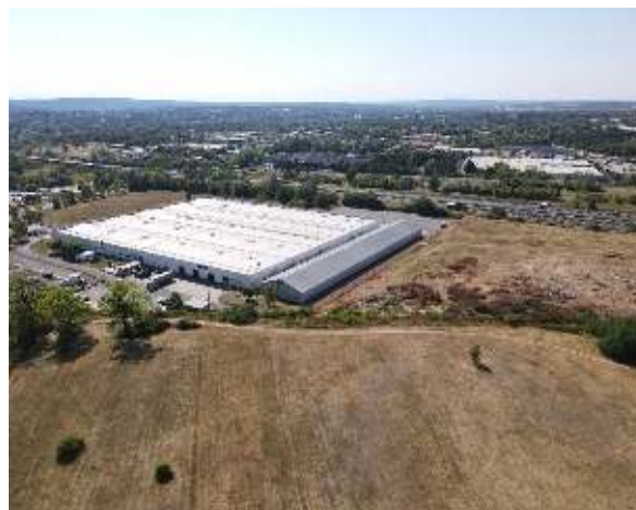
M3-as autópálya mindkét oldalán gazdasági terület (Gip, Gksz) építési övezetbe sorolt földrészek csarnok beépítéssel (saját fotó)
