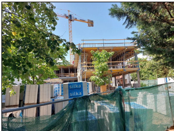
A bővítés I. üteme (saját fotó)
